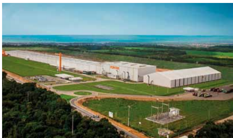
Planta industrial da Portobello, em Marechal Deodoro (AL), com cobertura e fechamento metálicos
