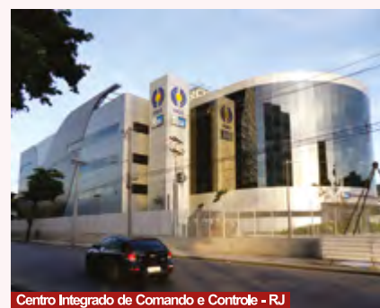
Centro Integrado de Comando e Controle - RJ
