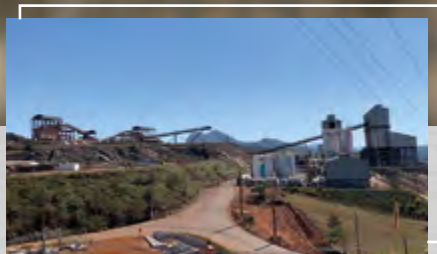
Anglo American: Sistema de despoeiramento e obras de Infraestrutura.
