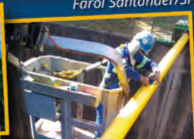
Manutenção de redes de gás
