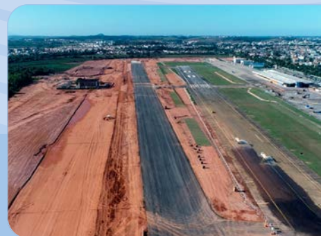
Obra de ampliação do Aeroporto de Macaé (RJ), nova PPD com 1.410m de comprimento e extensão do pátio de aeronaves em 10.000m². O projeto EPC foi executado pela Construtora Barbosa Mello.
