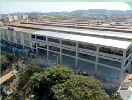
Geraes Construtora: Execução da expansão de Galpão Produtivo em estrutura pré-moldada de concreto, para o cliente Teksid, em Betim/MG.
