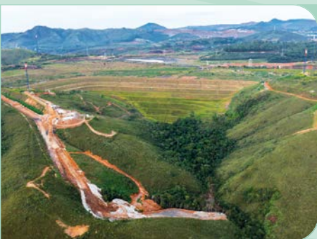
Barragem de disposição de rejeito de minério de ferro – Brasil. Estudos de Alternativas, Projetos Conceituais, Básicos e Detalhados da descaracterização da estrutura feitos pela Intertechne Consultores S/A
