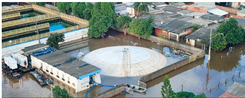
Segundo os engenheiros, as casas de bombas no RS, que possuem cerca de 8 m de profundidade, estavam todas com quase 2 m e meio de água acima delas.
