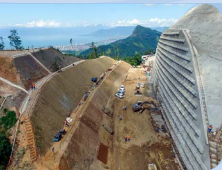
Cortina atirantada executada pela Tecnogeo na Rodovia dos Tamoios, Serra do Mar, Caraguatatuba (SP).
