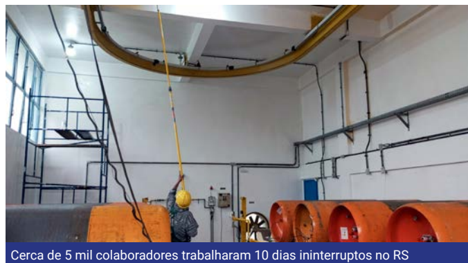
Cerca de 5 mil colaboradores trabalharam 10 dias ininterruptos no RS
