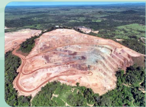
Fagundes Construção e Mineração S.A.: • EroBrasil: Mineração Caraíba - Projeto Boa Esperança; • Tucumã/PA; • PDE; Paiol de explosivo: Terraplenagem; Locação de equipamento; Pre-stripping e operação de mina; Dry stacking: escavação, preparação da base, confecção de drenos de fundo relacionados à pilha de dry stacking e instalação estrutural dos drenos.
