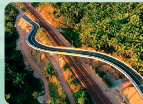
Quadrante Via ponte - Viaduto Rodoviário projetado sobre uma ferrovia de carga no norte do Brasil
