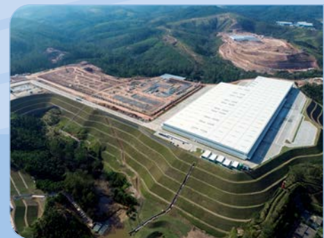
Afonso França Engenharia: Construção do condomínio logístico GLP Bandeirantes em Franco da Rocha/SP
